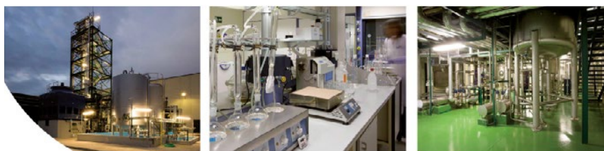
Figura 33. Centro de I+D+i de Biocombustibles y Bioproductos de ITACYL
